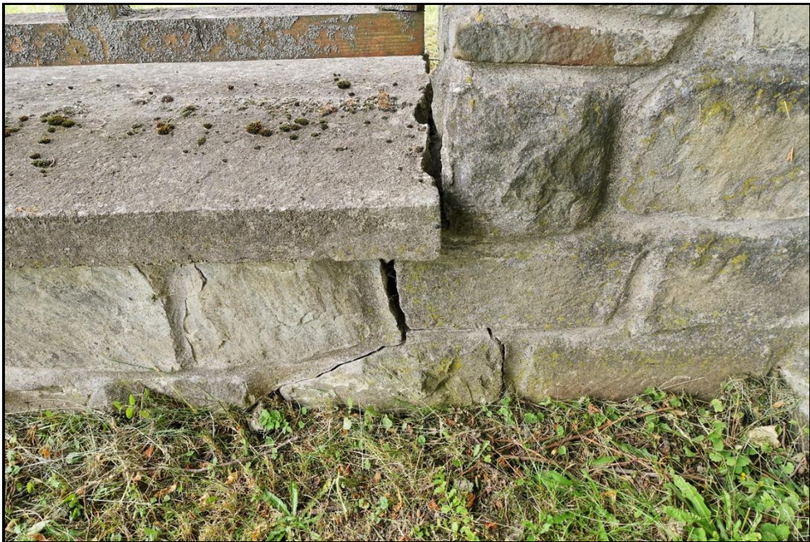
FOT. 71. CMENTARZ Z I WOJNY ŚWIATOWEJ NR 57 UŚCIU GORLICKIM Pęknięcie muru ogrodzenia, stan przed konserwacją.
