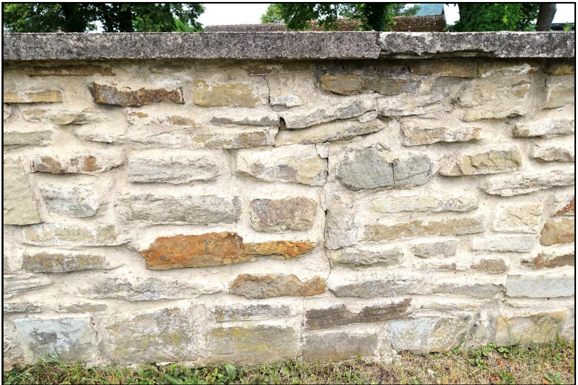
FOT. 74. CMENTARZ Z I WOJNY ŚWIATOWEJ NR 57 UŚCIU GORLICKIM Mur ogrodzenia wypełniony spoiną cementową, stan przed konserwacją. czerwiec 2021 r.
