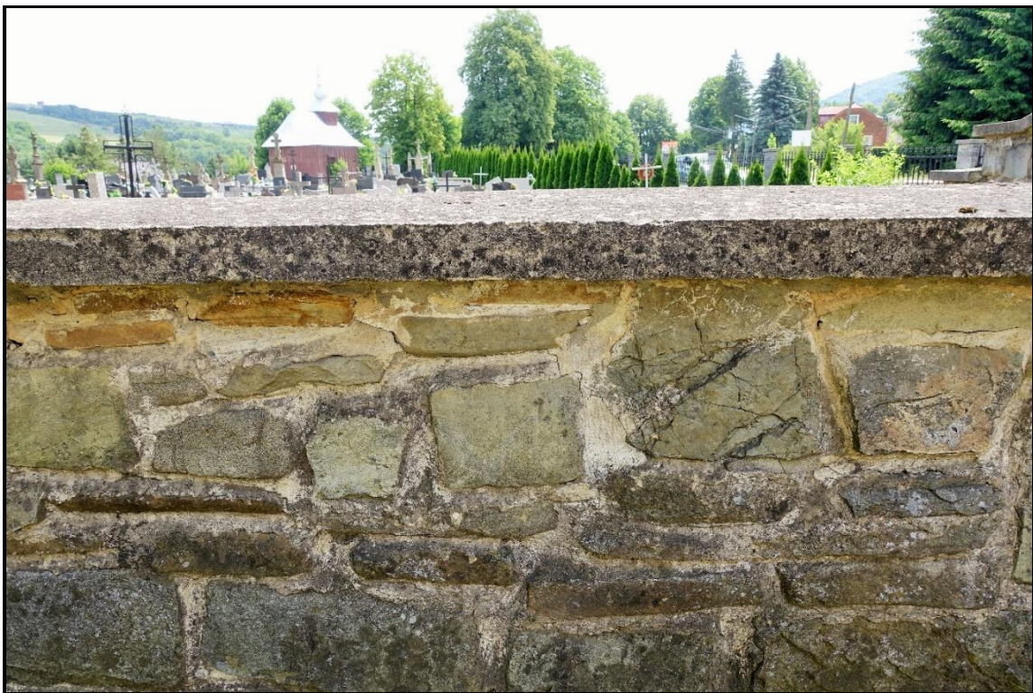
FOT. 72. CMENTARZ Z I WOJNY ŚWIATOWEJ NR 57 UŚCIU GORLICKIM Spoina cementowa muru ogrodzenia, stan przed konserwacją.
