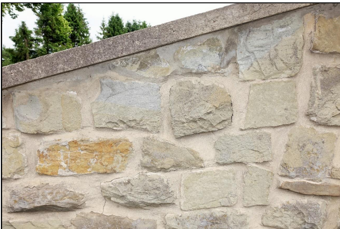
FOT. 76. CMENTARZ Z I WOJNY ŚWIATOWEJ NR 57 UŚCIU GORLICKIM Mur ściany pomnikowej wypełniony spoiną cementową, stan przed konserwacją. czerwiec 2021 r.
