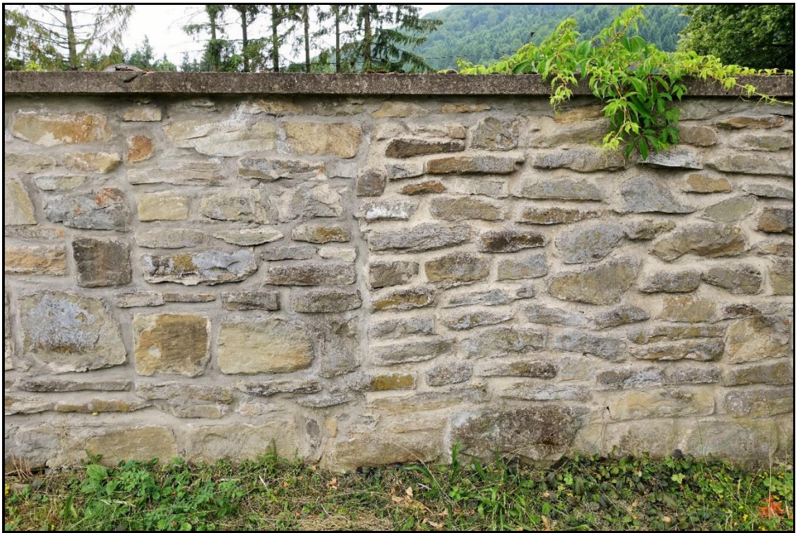
FOT. 73. CMENTARZ Z I WOJNY ŚWIATOWEJ NR 57 UŚCIU GORLICKIM Mur ogrodzenia wypełniony spoiną cementową, stan przed konserwacją. czerwiec 2021 r.
