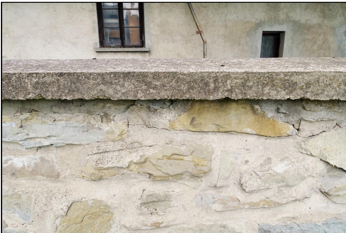
FOT. 75. CMENTARZ Z I WOJNY ŚWIATOWEJ NR 57 UŚCIU GORLICKIM Mur ogrodzenia wypełniony spoiną cementową, stan przed konserwacją. czerwiec 2021 r.
