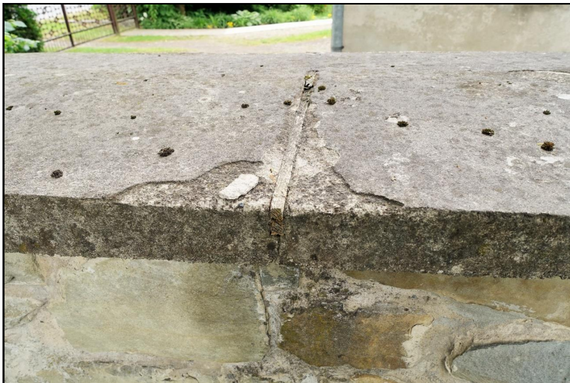
FOT. 77. CMENTARZ Z I WOJNY ŚWIATOWEJ NR 57 UŚCIU GORLICKIM Zniszczona nakrywa muru ogrodzenia, stan przed konserwacją.
