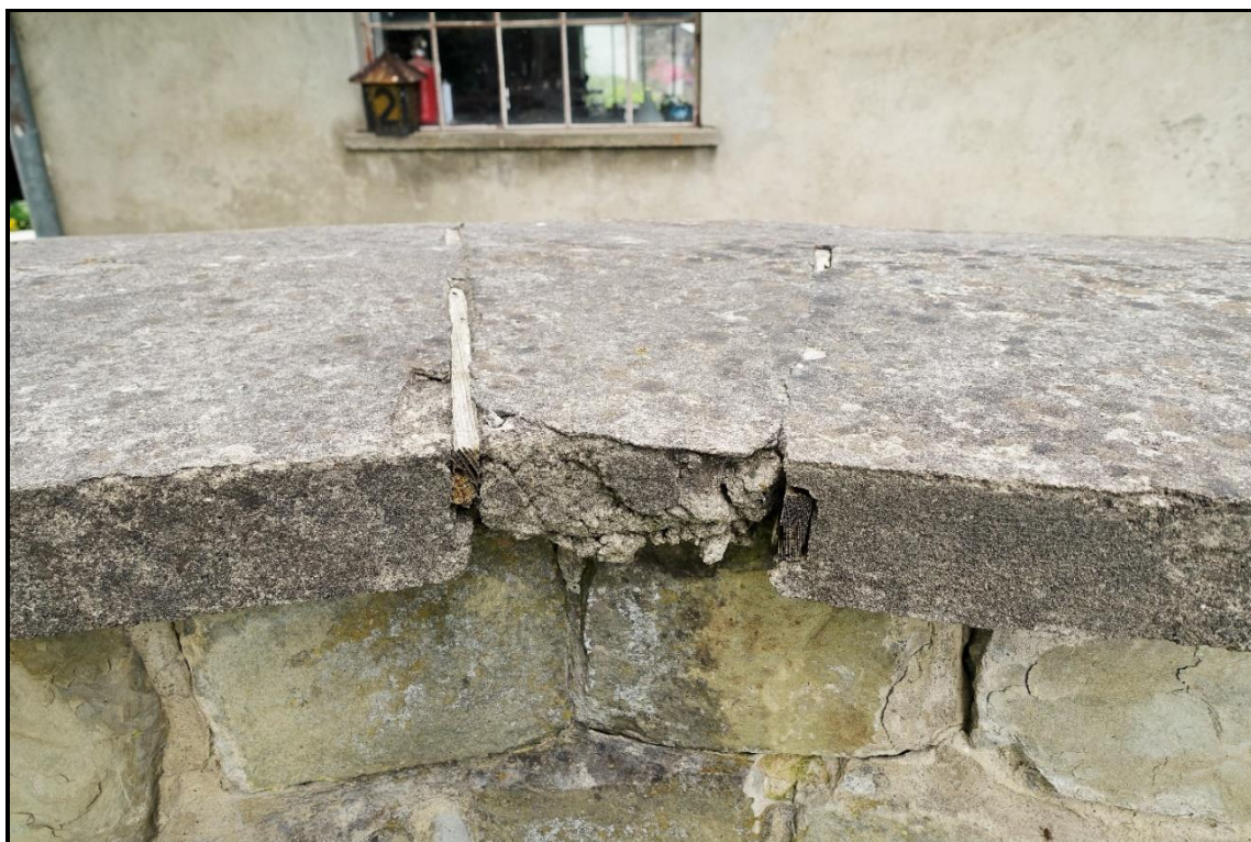
FOT. 78. CMENTARZ Z I WOJNY ŚWIATOWEJ NR 57 UŚCIU GORLICKIM Zniszczona nakrywa muru ogrodzenia, stan przed konserwacją.
